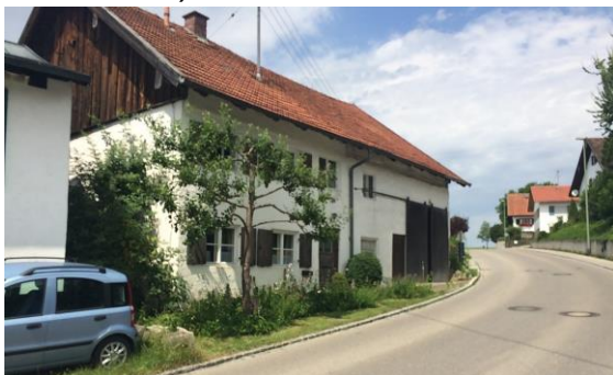
Abb. 66: Traufständige Gebäudestellung an der Obergasse in Unterfinning
