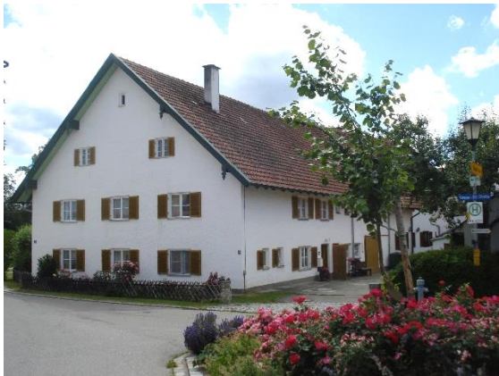
Abb. 20: Alte Hofstelle in der Kaspar-Ett-Straße
