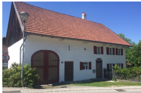
Abb. 79: Mitterstallhaus in Oberwindach (Hechenwanger Straße)
