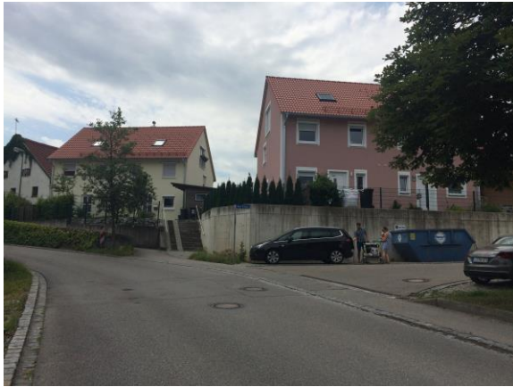
Abb. 211: Situation „Beim Kramer“, Bestand
