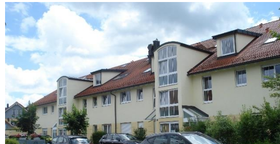
Abb. 38: Untypische Mehrfamilienhäuser in Oberwindach
