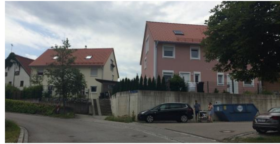
Abb. 163: Neubebauung und Betonmauer „Beim Kramer“
