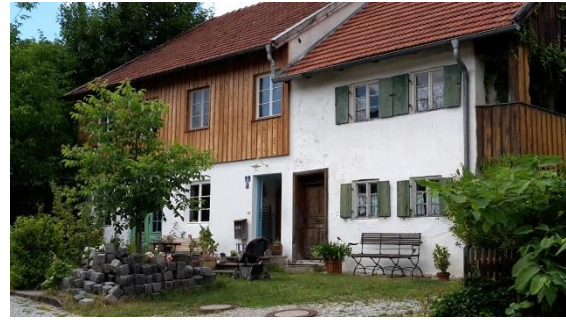
Abb. 21: Der regionaltypischen Bauform entsprechendes, teilsaniertes Wohnhaus
