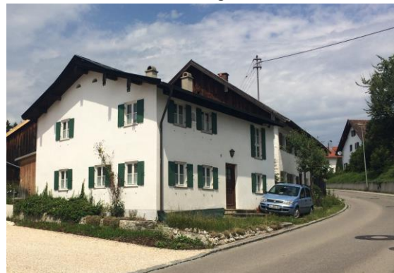
Abb. 80: Ehemaliges Tagelöhnerhaus in Unterfinning (Obergasse)
