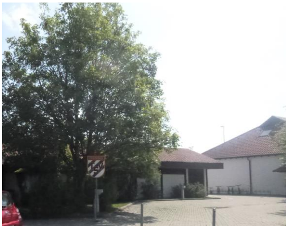
Abb. 71: Gemeindezentrum mit Schule, Feuerwehr, Vereinsheim und Kindergarten
