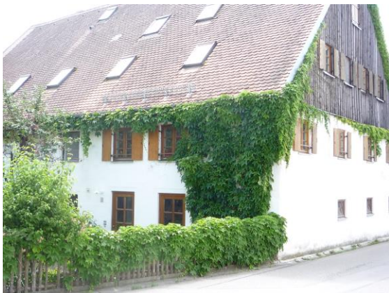
Abb. 82: Typisches Bauernhaus in Unterwindach (Schulstraße)
