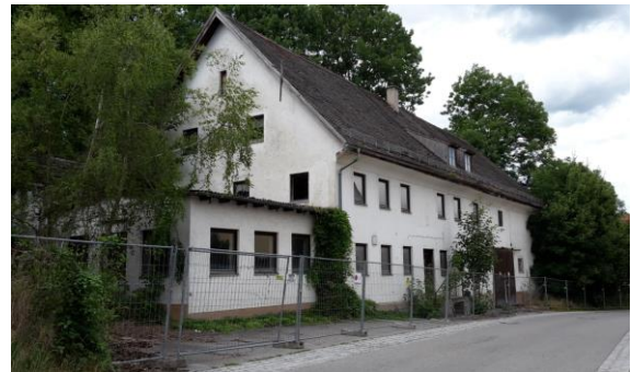
Abb. 138: Sanierungsbedarf „Alter Wirt“
