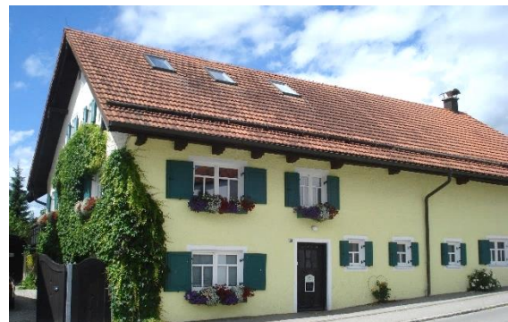
Abb. 68: Ortsbildprägendes traufständiges Gebäude in Unterfinning
