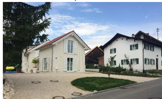
Abb. 69: Neubau, in Stellung und Ausprägung untypisch für das Ortsbild und den Straßenraum (Raumkante aufgegeben)
