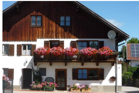
Abb. 152: Ortsbildprägendes Gebäude an der Pfarrgasse
