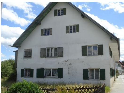
Abb. 83: Typische Gebäudeform in Eresing (Hauptstraße)
