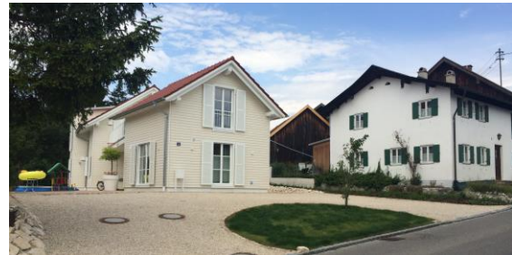
Abb. 164: Ortsbilduntypisches Gebäude an der Obergasse, fehlende Raumkante
