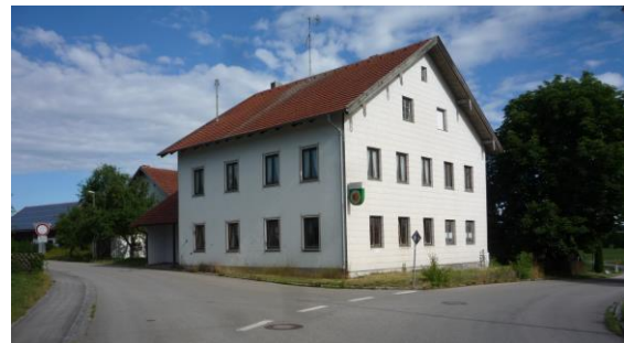
Abb. 170: Sanierungsbedarf ehemaliges Gasthaus und Vorbereich
