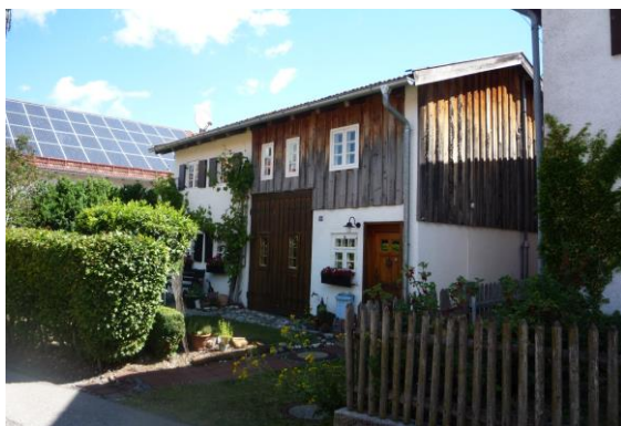
Abb. 78: Mittertennhaus an der Pfarrgasse in Oberfinning
