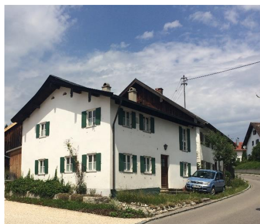
Abb. 4 Kleines Bauernhaus in Unterfinning, Obergasse 13
