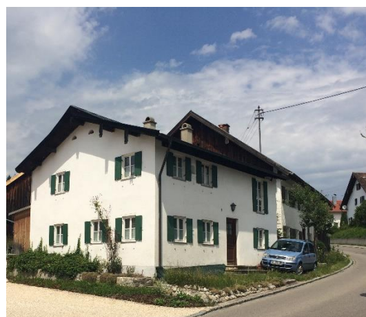
Abb. 4 Kleines Bauernhaus in Unterfinning, Obergasse 13
