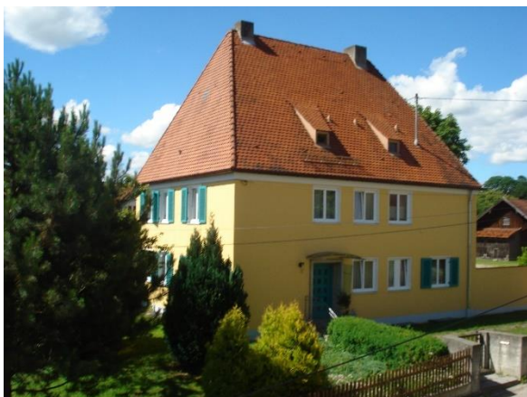
Abb. 5 Ehemaliges Pfarrhaus in Oberfinning, Kirchsteig 2
